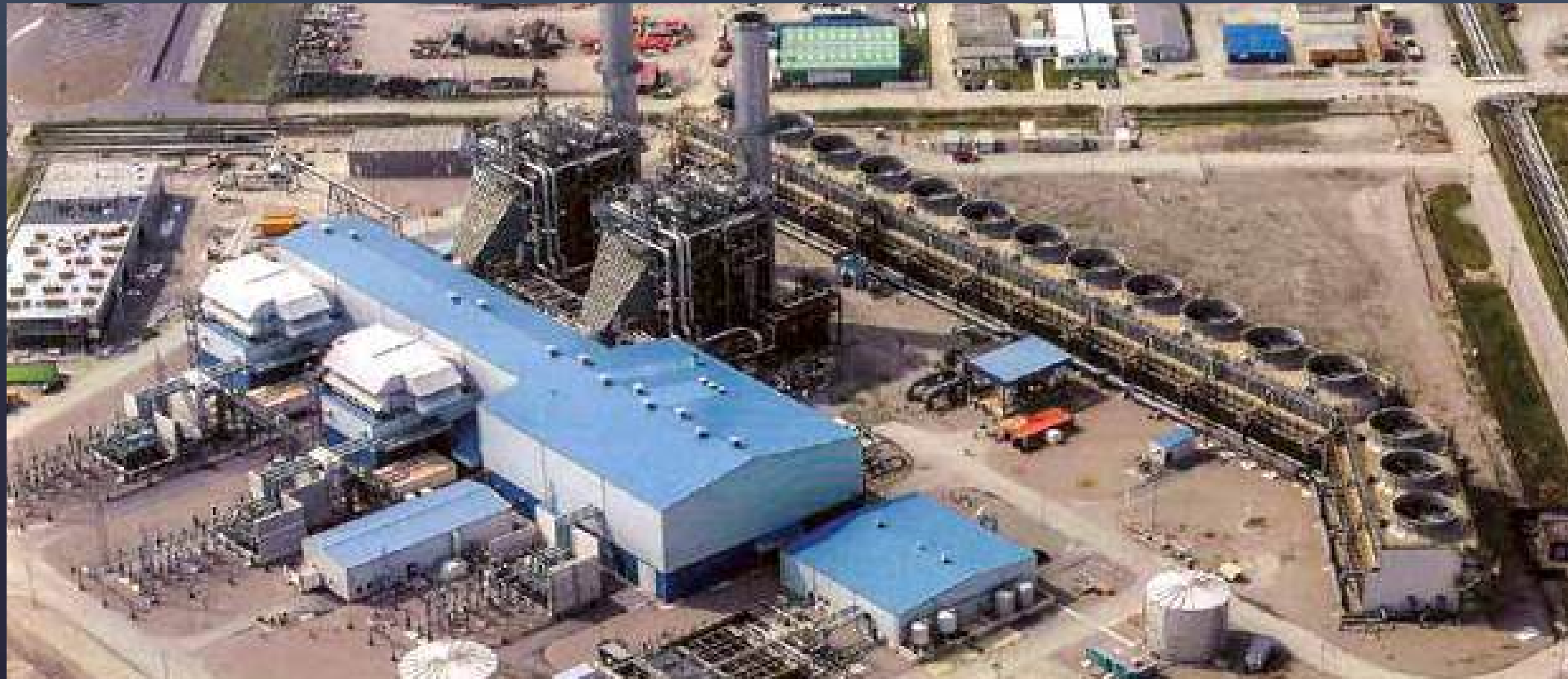
RIJNMOND CCPP 770 MW
